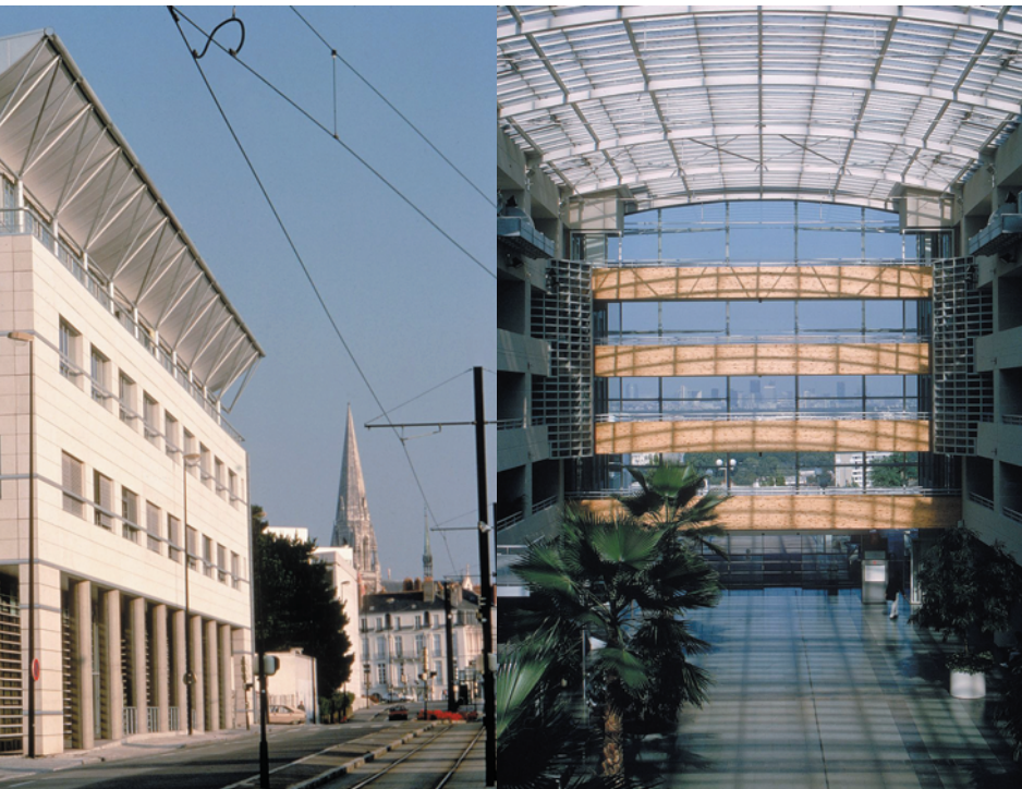
Centrum Szpitalne i Uniwersyteckie w Nantes, proj. Samir FARAH Architecte - DPLG (fot. lewa) Szpital wojskowy de Percy – Paris – Clamart, proj. Samir FARAH Architecte - DPLG (fot. prawa) Współpraca projektancka inż. Artur Słabiak
